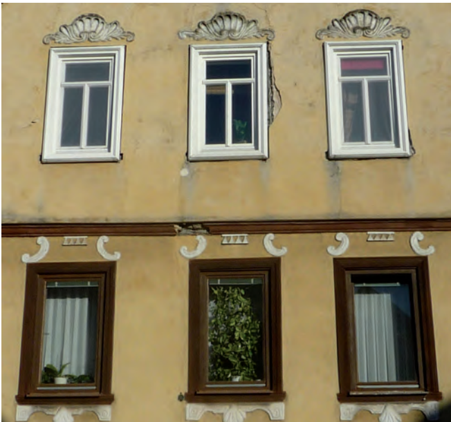
Erhaltenswerte Fassadendetails machen Aussendämmung problematisch
